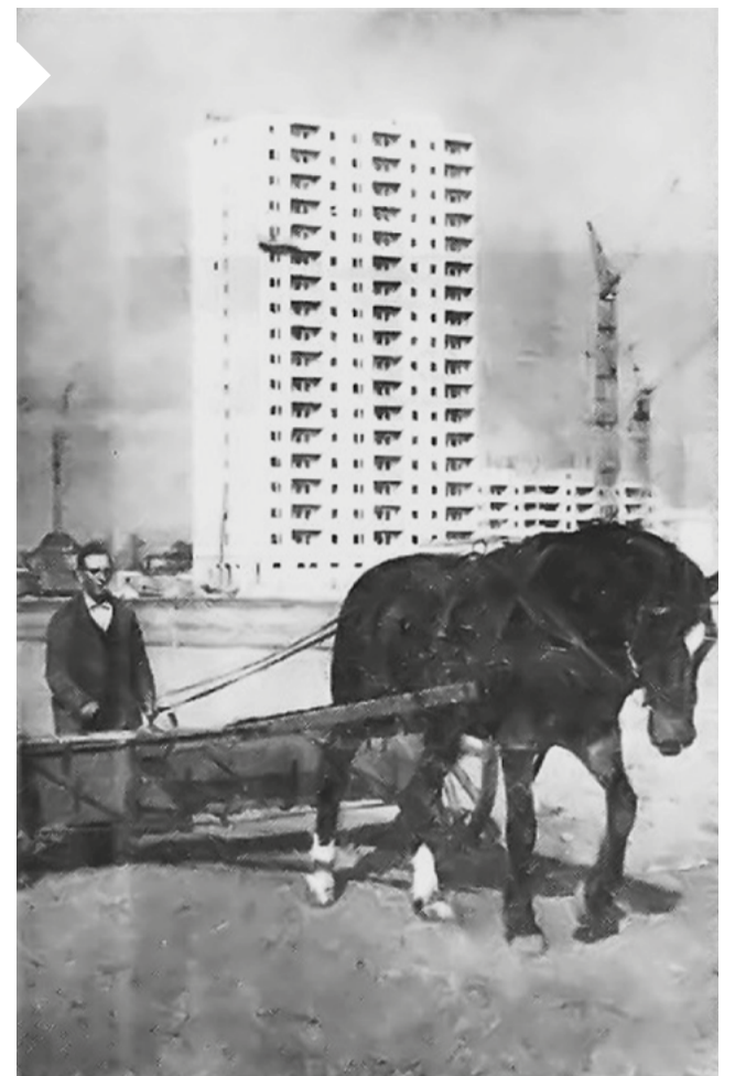
• So sah es in der Siedlung aus, als Frau Schwark einzog. Hier ein Bild vom Bau der Barnetstraße 68 (Quelle BZ 1965)
