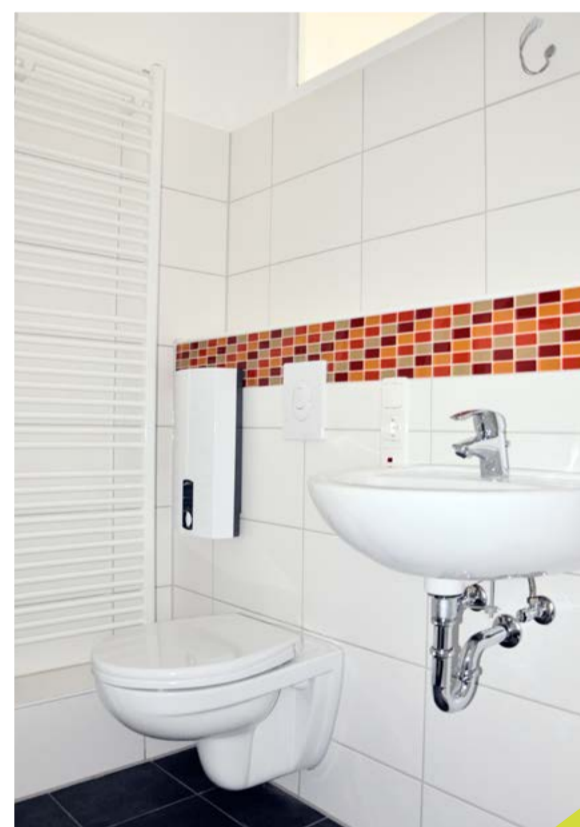
Blick in ein frisch saniertes Bad
